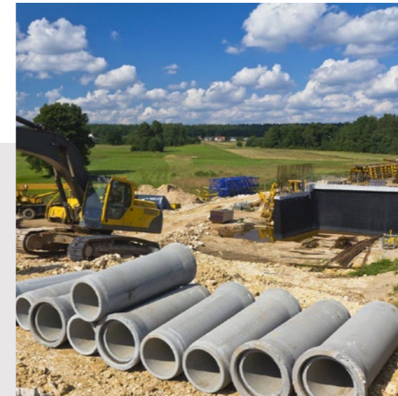
// Straßen-, Brücken- und Gleisbau
